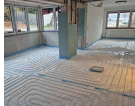
Blick ins erweiterte Büro mit den Schlangen für die Fußbodenheizung
