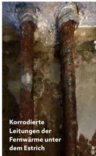
Korrodierte Leitungen der Fernwärme unter dem Estrich
