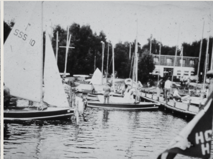
3. 1962 wurde die SSS neu eröffnet, nun wieder in Steinhude
